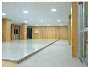
大規模改修工事(西昇降口)
