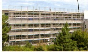
大規模改修工事1
