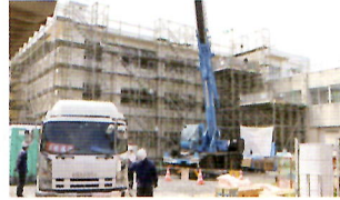
大規模改修工事2
