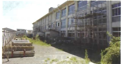
9月:耐震補修工事 D棟・E棟の工事開始
