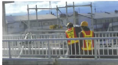
第2期除染作業 屋上除染
